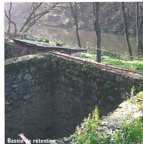
Bassin de rétention
