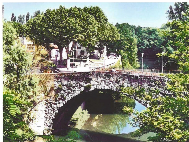
Le Pont Vieux
